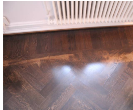
Huono hionta reuna- ja nauhakoneen saumassa ja huolimattomasti tehty esikastelu näkyvät suurena värieroina.
